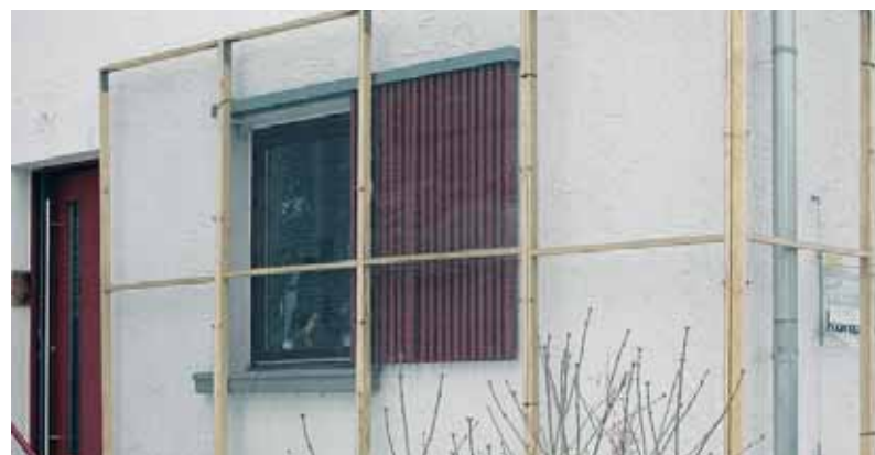
Das Arbeitszimmer in der Meßkircher Straße 9 ist mit Hasendraht gegen die Senderstrahlung abgeschirmt. FOTO: SZ
