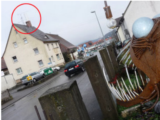
Nichts zu machen: Der Mobilfunkmast in Laiz in der Meßkircher Straße unterschreitet in Sachen Strahlung die Grenzwerte deutlich. (Foto: Michael Hescheler)
