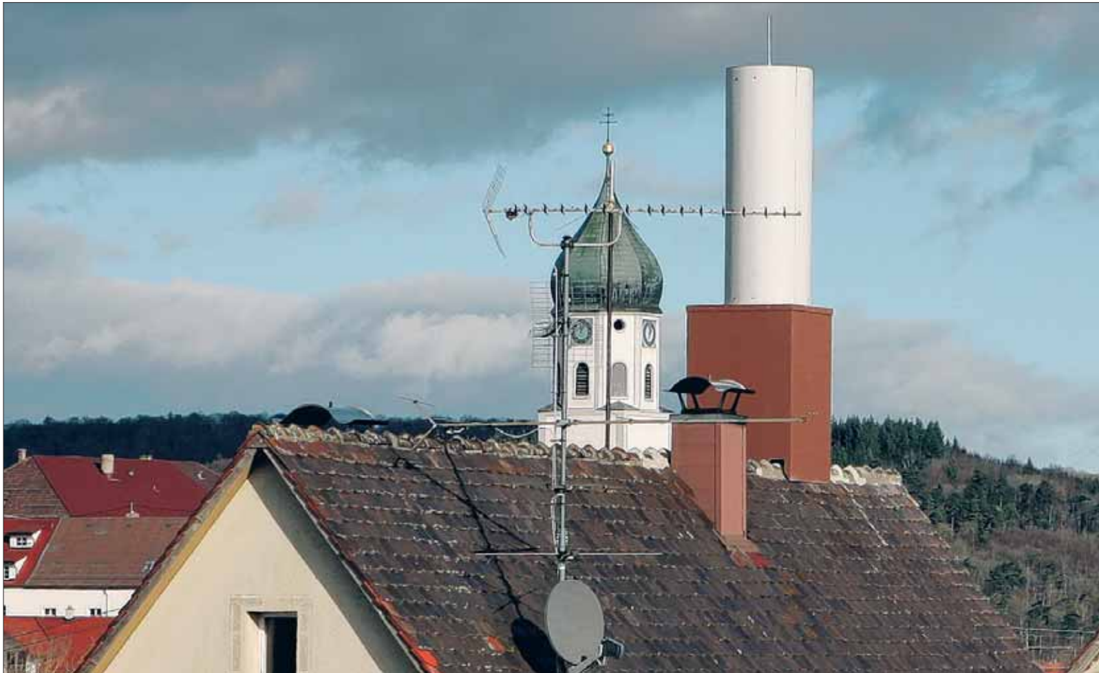
Sieht unscheinbar aus, sorgt aber für Ärger unter den Anwohnern: Eine Sendeanlage auf dem Dach eines Hauses.
